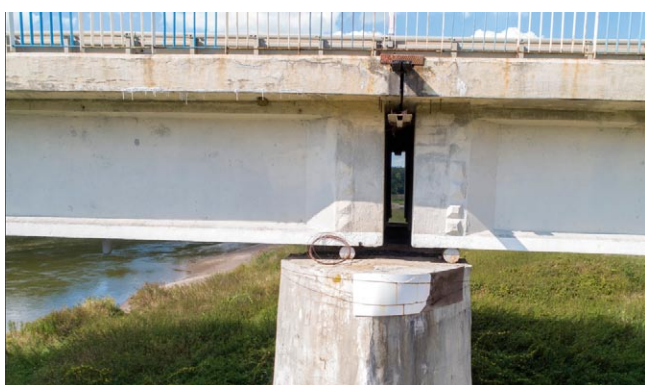
Rys. 2. Widok z powietrza na elementy podparcia przęsła mostowych na podporach
